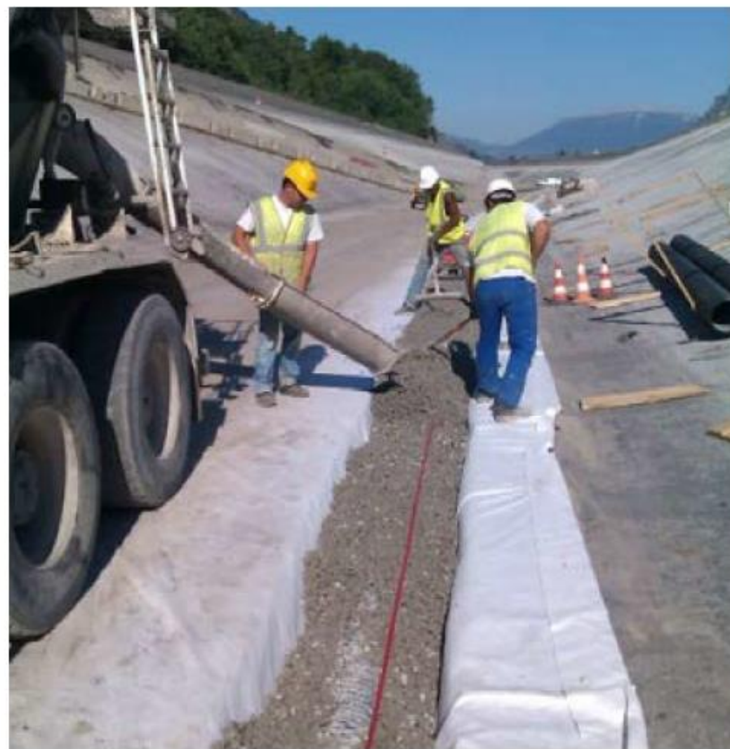
Pose de la fibre optique dans les tranchées drainantes
